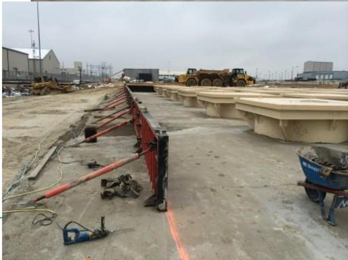
Behälter werden einzeln im Boden versenkt
