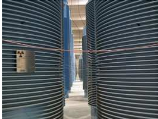
Halle 8 des Transportbehälterlagers im ZLN mit 74 CASTOR® -Behältern
