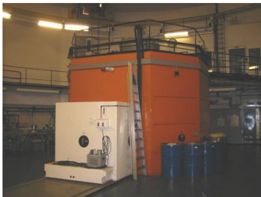
Reaktorblock des Forschungsreaktors Frankfurt zu Beginn (Bild links) und nach Abschluss der Rückbauarbeiten (Bild rechts)
