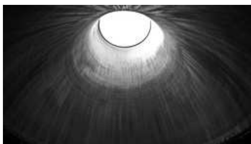
Das Innere eines der beiden Nasskühltürme des KKW Grafenrheinfeld
