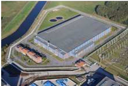
Gesamtansicht Zwischenlager Nord
